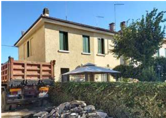
Vista esterna da Nord-Ovest
